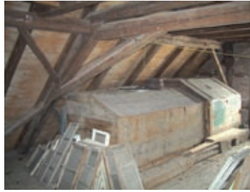
2002 - Der Dachboden vorher
